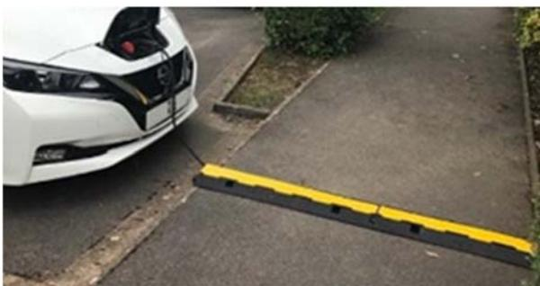
Le premier consiste à placer un **pont temporaire** au-dessus du câble, permettant d'adoucir l'obstacle pour le piéton et de limiter le risque de détérioration et d'électrocution. Cette solution n'est pas idéale en ce que le cheminement piéton reste inconfortable, voire dangereux, en particulier pour les personnes à mobilité réduite.
