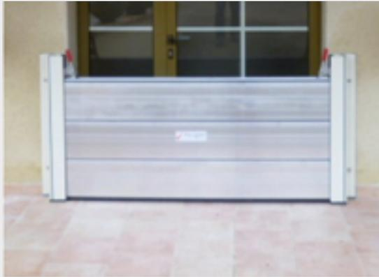
*La hauteur des batardeaux ne doit pas dépasser 70 cm car ils doivent pouvoir être enjambés aisément par les occupants et secouristes.*
