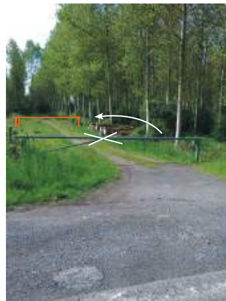
Situation actuelle dangereuse. Après travaux, la barrière a été reculée de 25 m de la route.
