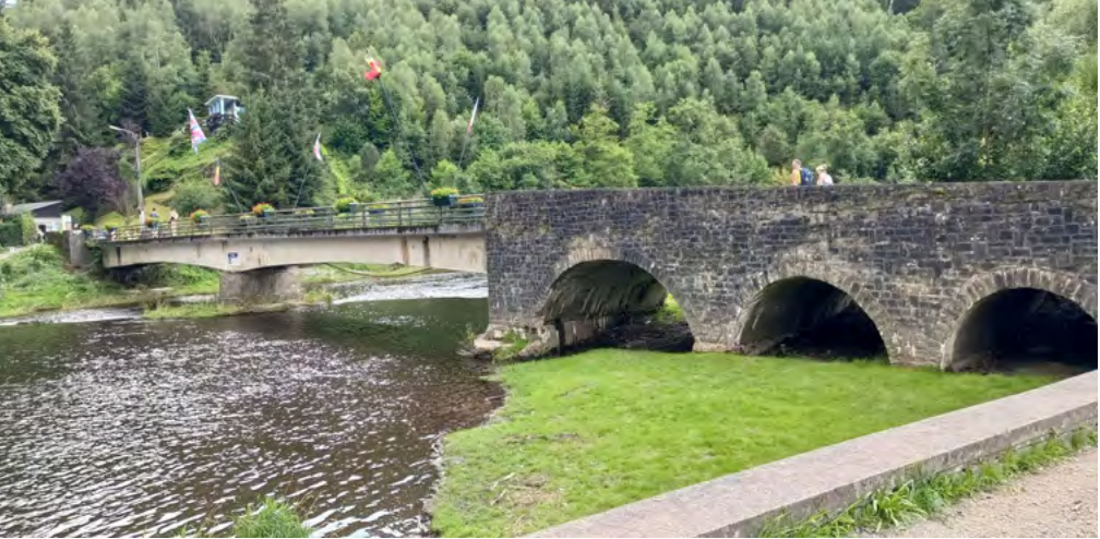
Pont route de Maboge à La Roche-en-Ardenne.
