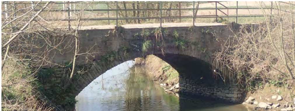
Voûte en maçonnerie à Rebecq.
